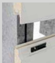
A panelek vízszintes felszerelése
